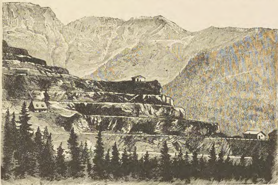
Fig. 136. Tagbau auf Spateisenstein im Erzberg bei Eisenerz.
